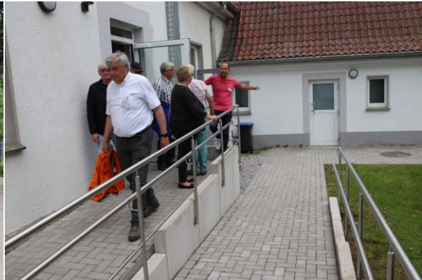
Barrierefreier Zugang Dorfhaus
